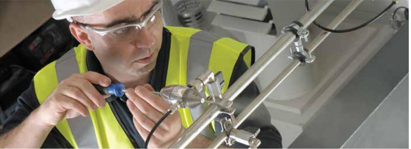
Junto a un diseño, instalación y puesta en servicio profesionales, un sistema de humidificación comercial requerirá una asistencia y mantenimiento regulares para que siga siendo eficiente e higiénico. Se deberá incluir un esquema de mantenimiento no solo para el humidificador, sino también para cualquier planta asociada, como los filtros de agua de ósmosis inversa.
