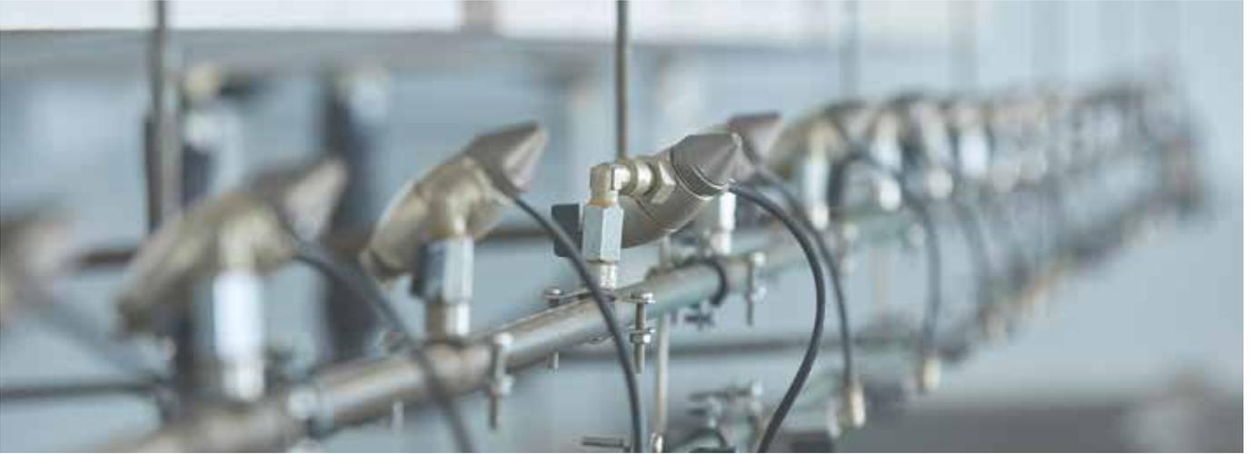
Con el objetivo de usar satisfactoriamente el flujo de aire de los refrigeradores como mecanismo de transporte de los aerosoles en la estancia, es importante colocar las boquillas de nebulización correctamente.
