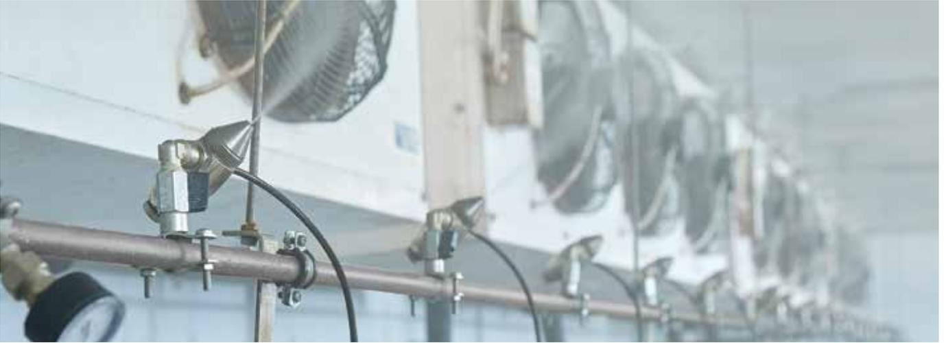
En una zona de refrigeración primaria, el aire procedente de los refrigeradores estará normalmente a unos 0-2 °C y estará saturado al 100 % de humedad relativa (%HR). En estas condiciones, un metro cúbico de aire podrá contener como máximo 4,5 g de humedad. Es imposible aumentar el volumen de vapor de agua en el aire más allá de esta cantidad cuando está a una temperatura tan baja.
