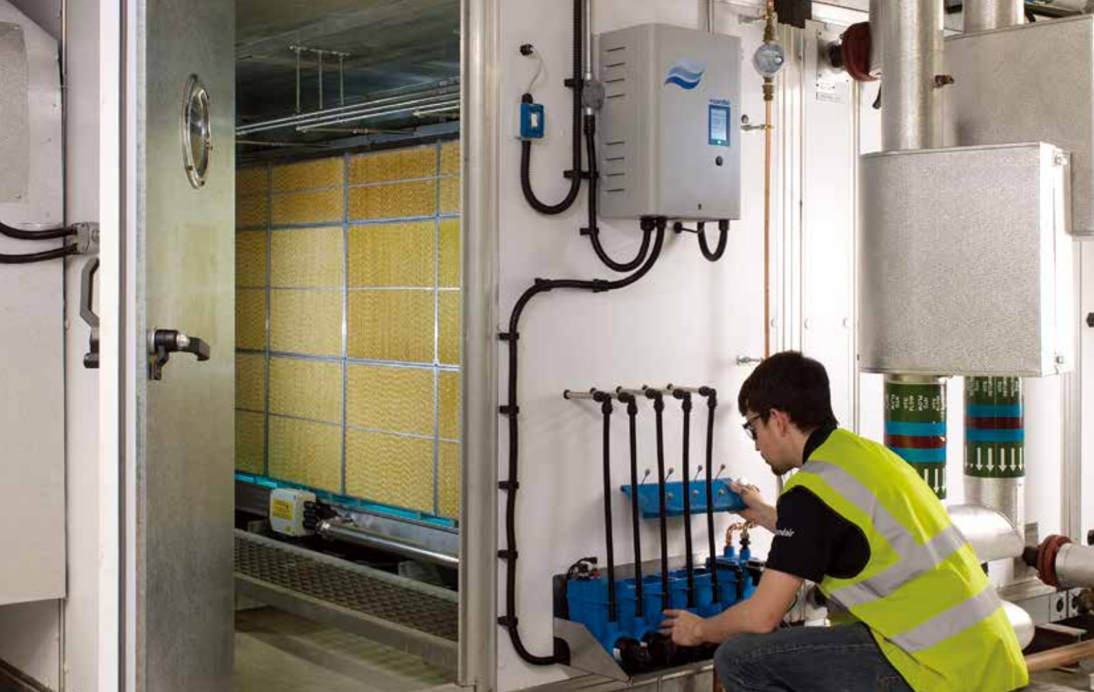
Condair ME con unidad hidráulica montada externamente
