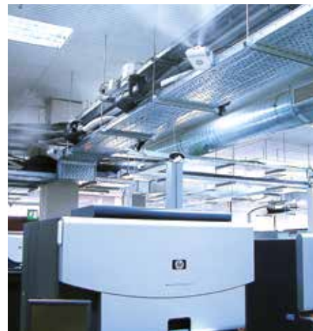
La humedad óptima protege los sistemas de impresión digital de la electrostática
